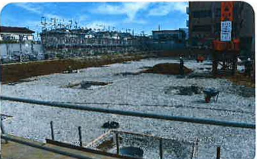
基礎部分の整地(耐震構造の工事)
